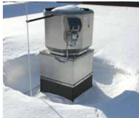
Ventilatsioonisüsteemide juurest sulab lumi ära kõige kiiremini. Kergema lume puhub ventilaator lihtsalt minema.
