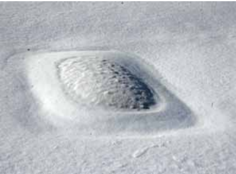
Paksu lumekihi alt on umbes 60...70 cm kõrgune katuseaken vaevu hoomatav.
