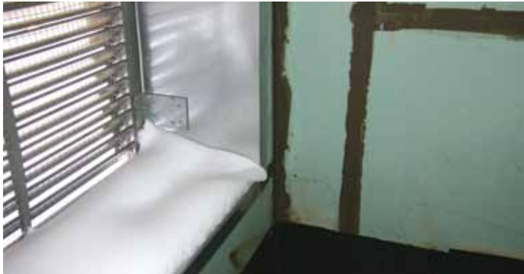
Lumerohketel talvedel ja tuisuga võib lumi sattuda ka ventilatsioonisüsteemi sissepuhkekambritesse. Seepärast tuleb kambri põrandad hüdroisoleerida.
