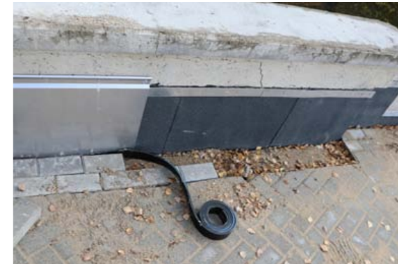
Hüdroisolatsiooni ülespöörded on ülaservas kindlustatud 1,5 mm plekiribaga ja tihendatud bituumenmastiksiga. Kõige lõpuks asetatakse ka katteplekk. Sillutise ja pinna vahele paigaldatakse kaitseks SBR kummiriba.
