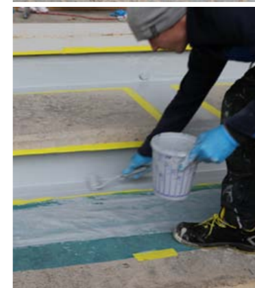
Hüdroisolatsiooni ülespöörded on ülaservas kindlustatud 1,5 mm plekiribaga ja tihendatud bituumenmastiksiga. Kõige lõpuks asetatakse ka katteplekk. Sillutise ja pinna vahele paigaldatakse kaitseks SBR kummiriba.
