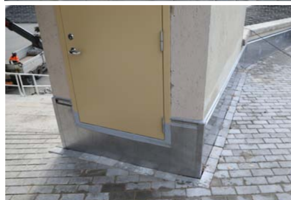
FOTO ÜLEVAL VASAKUL: Seina katteplekkide pesu enne objekti üleandmist.
