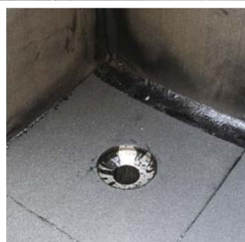
Äravoolehtri alumise astme ääriku liide pealiskihi hüdroisolatsiooniga.
