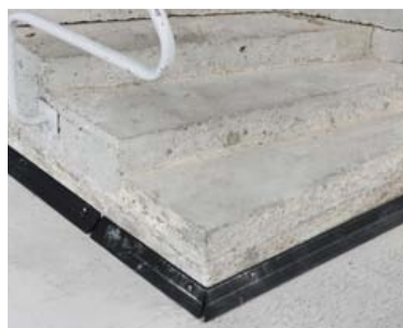
Renoveeritud ja renoveeritava osa liitekoht tööde käigus
