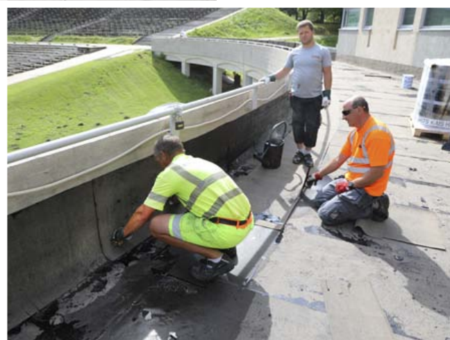
Kuumliimitav bituumenrullmaterjal paigaldatuna
