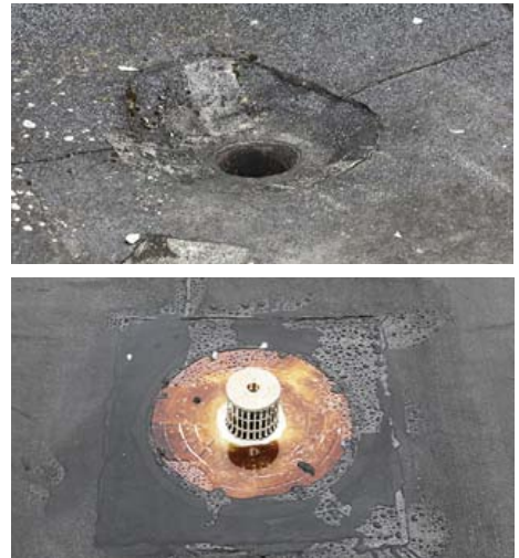
Vanad katuslage läbivate äravoolulehtrite detailid on asendatud uute nüüdisaegsete kaheastmeliste äravooludega. Foto on tehtud Aardla 7 a objektil Tartus.
