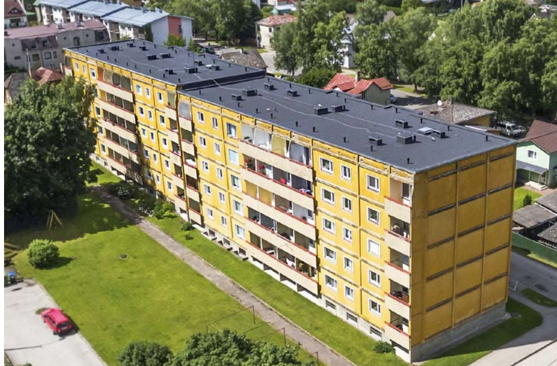
Droonifoto KÜ Nõva 13/1 renoveeritud katusest.
