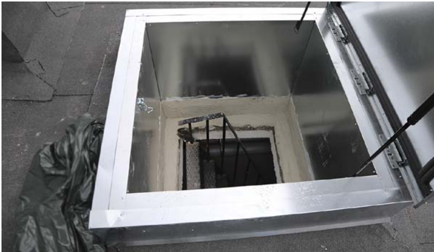
Uus katuseluuk KK 1x1. Luugil on kolm hinge, topelthhend, kaks tugevat õhk-silindrit ja piimanõusulgur. Saht ja luugikaas on soojustatud mineraalvillaga. Foto on tehtud Aardla 7 a objektil Tartus.
