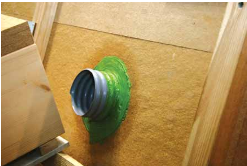
Läbiviigu tihendamine tuuletõkkeplaadist
