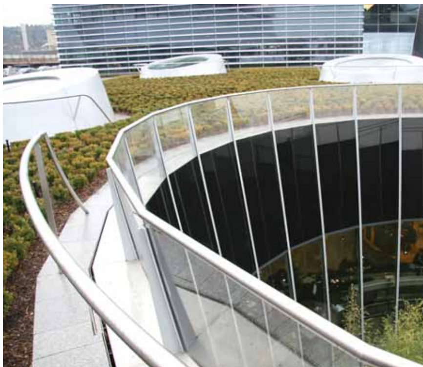
Sama aatrium lähivaates Päärde ees on näha äravoolurenn.
